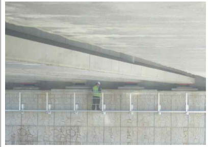
▲ 교량받침 점검로 근접조사
