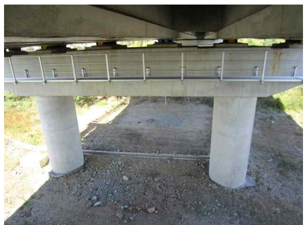
교량 하부 전경
