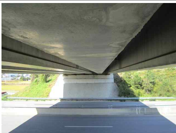
교량 하부 전경
