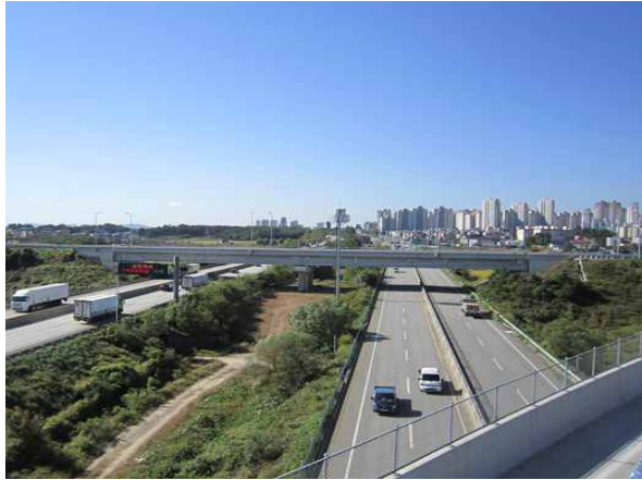
교량 측면 전경
