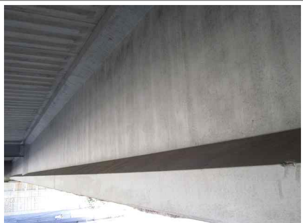
교량 거더 전경
