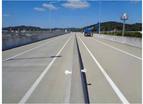
교량 상부 전경
