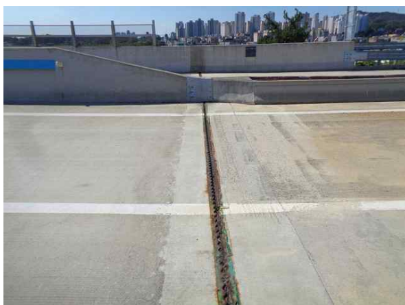
교량 상부 전경
